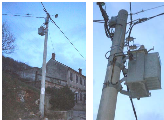
Slika 7. Jednofazni transformator prijenosnog omjera 230/950 V
