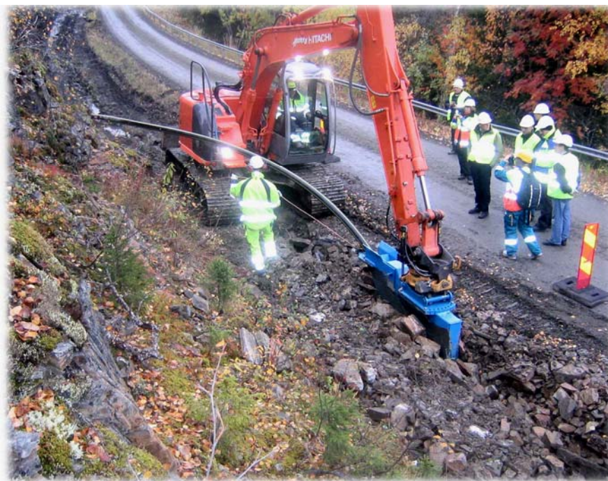
Slika 6. Pluženje s polaganjem ojačane plastične cijevi
