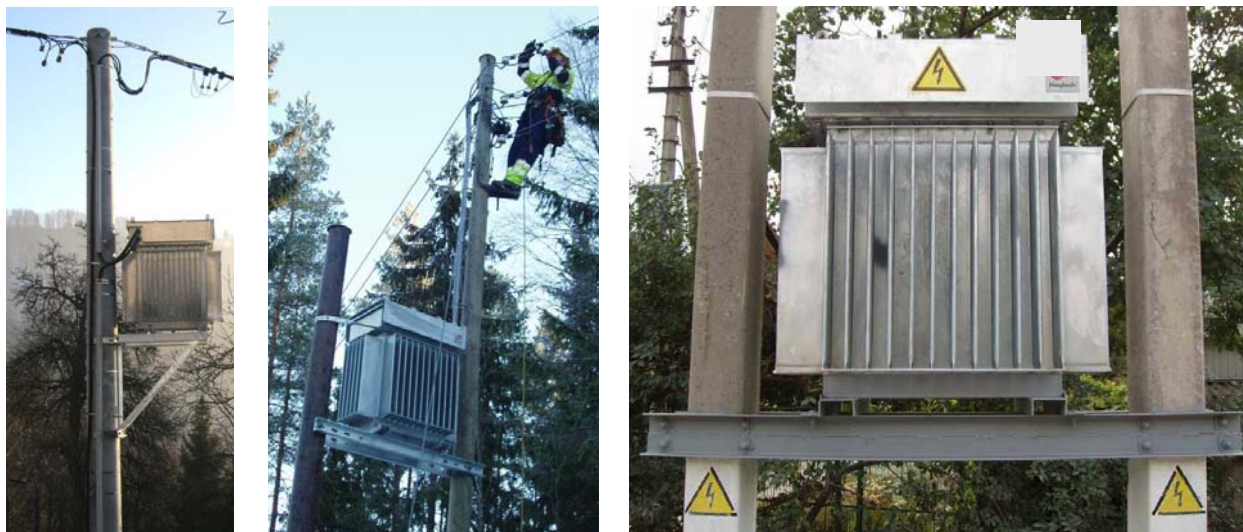
Slika 4. Primjeri ugradnje naponskog stabilizatora u niskonaponskoj mreži
