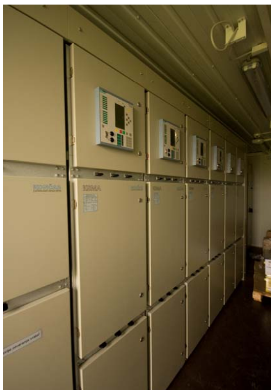
Slika 8. Detalj postrojenja, sklopni blokovi 10(20) kV
