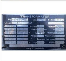
Natpisna pločica transformatora
