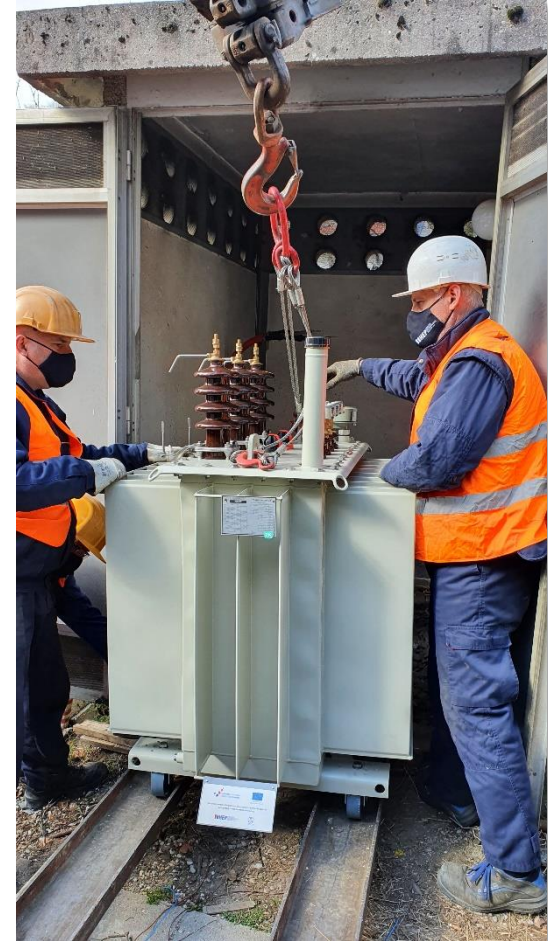
Slika 12.: Ugradnja transformatora u sklopu pilot projekta u Elektri Zagreb
