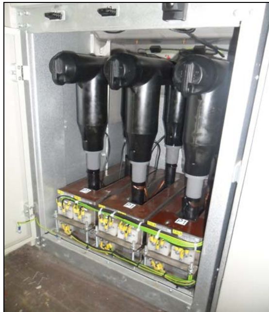
Slike 6. i 7. Priključak TR 110/10(20) kV na 10(20) kV postrojenje
