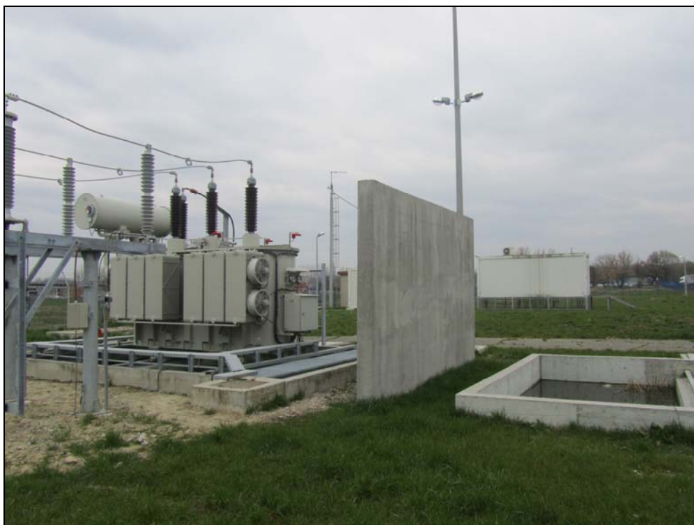
Slika 4. TR 110/10(20) kV 1x20 MVA sa montažnim objektom SN postrojenja u pozadini
