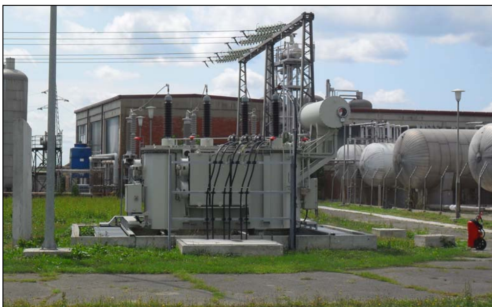
Slika 5. TR 110/10(20) kV 1x20 MVA oprema i priključak 10(20) kV
