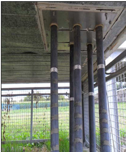
Slike 6. i 7. Priključak TR 110/10(20) kV na 10(20) kV postrojenje
