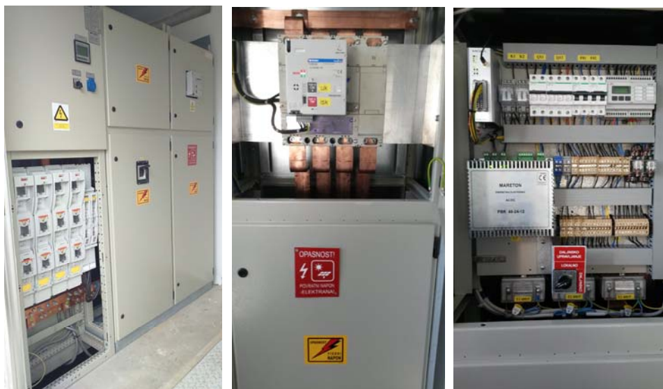
Slika 4. Niskonaponski ormar na sučelju solarne elektrane „Limont“ na mrežu
