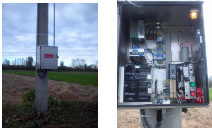
Slika 3. Motorni pogon prigraden rastavljaču i pripadajuća sekundarna oprema
